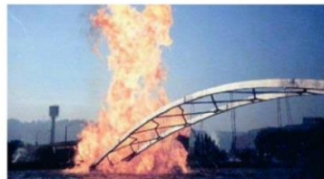
■ Le pont de Vivegnis après l'explosion. © D.R.
